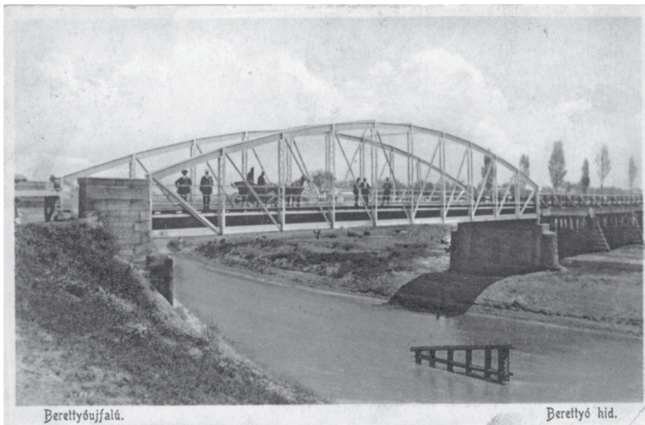
6. kép. Berettyóújfalú, Berettyó-híd
